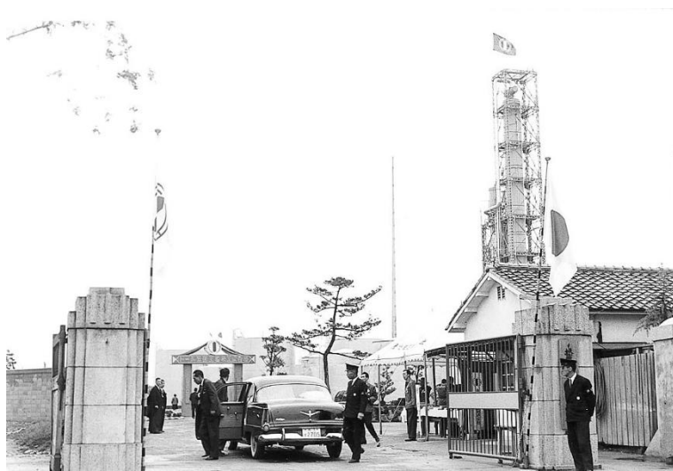
トール油精留プラント竣工式当日 1959年4月16日
