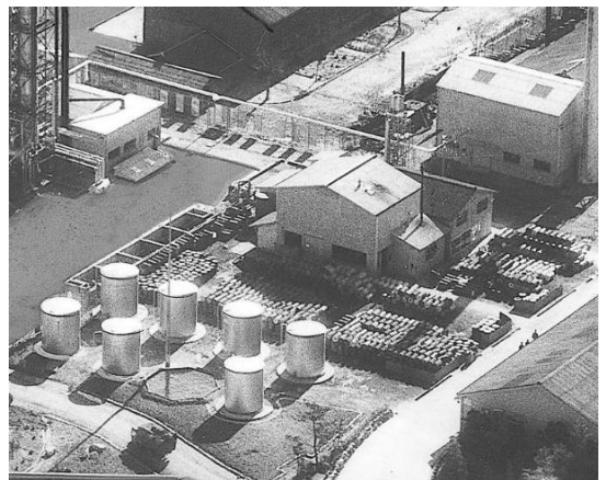
フタル酸樹脂工場
