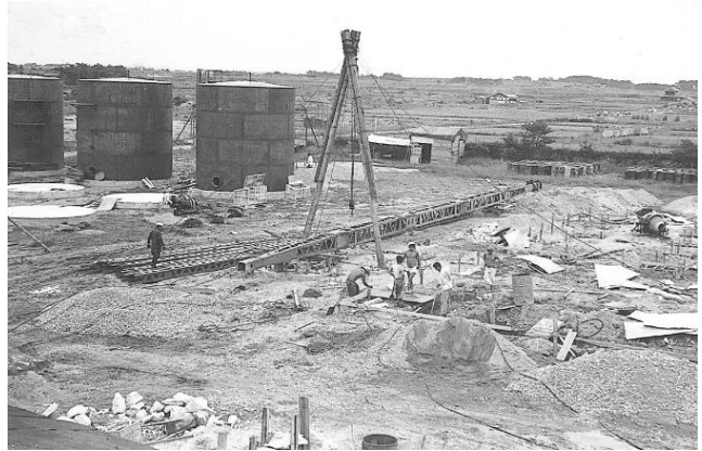
トール油精留プラント建設工事現場 1958 年
