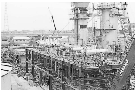
建設中のトール油精留プラント
