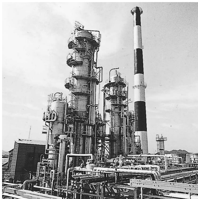
完成したトール油精留プラント
