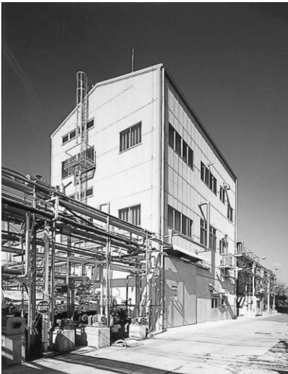
ケーシー 本社工場
