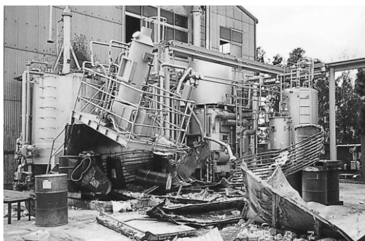
ポリアミド工場のドラム缶破裂事故
