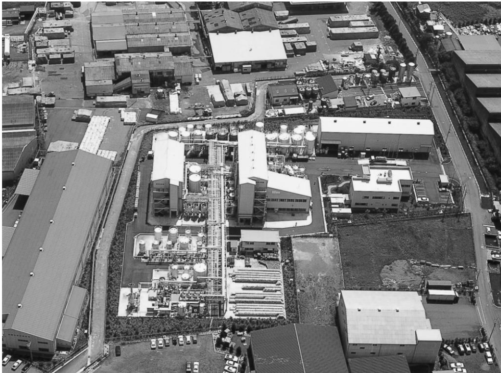
完成した新富士工場
