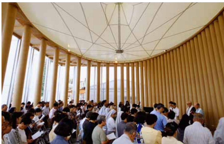
高さ5メートルの紙管58本を楕円形に配した、神戸市鷹取教会内に建てたコミュニティホール。『紙の教会』（撮影：Hiroyuki Hirai）
