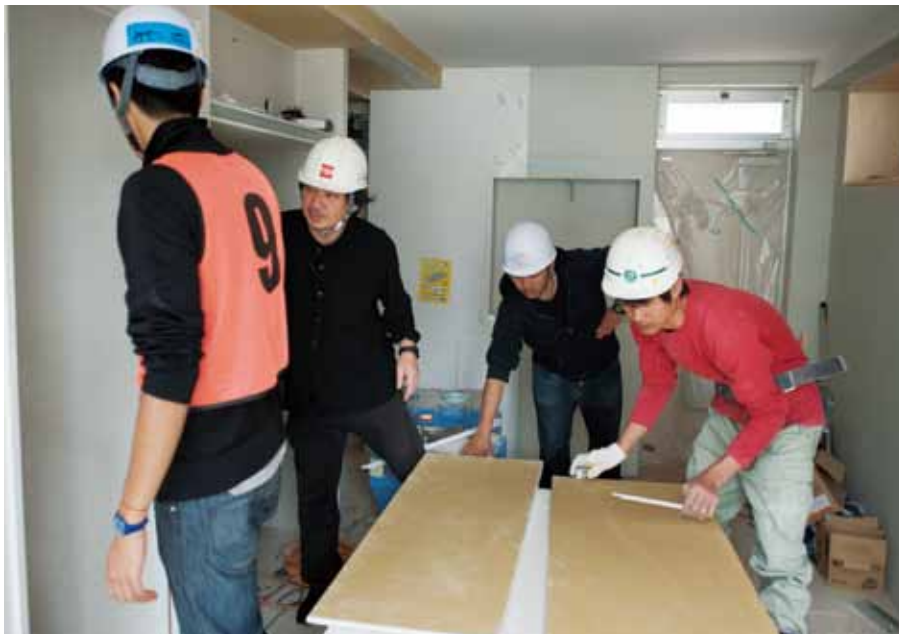
現場に着くなり仮設住宅の進捗具合を確認する。
