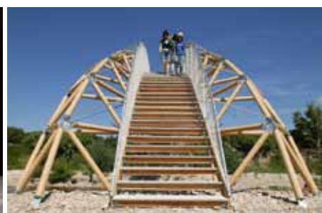
紙管281個で構成されている、南仏 ガルドン川に架かる。『Paper Bridge』（撮影：Didier Boy de la Tour）
