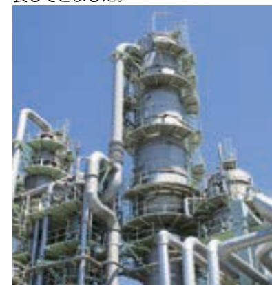
1958年に国内初トル油精留プラントを完成し、1973年に世界初「完全クローズドシステム」トル油精留プラント建設。現在も資源循環型事業の高度化を継続。
